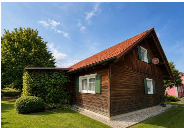
Hausansicht im Osten
