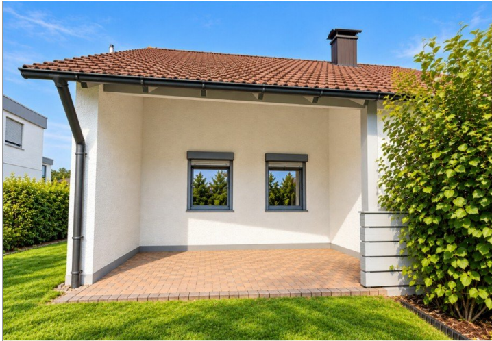
EG überdachte Terrasse
