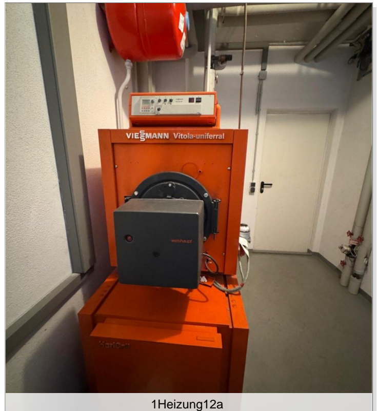
ÖLzentralheizung DHH rechts (1)
