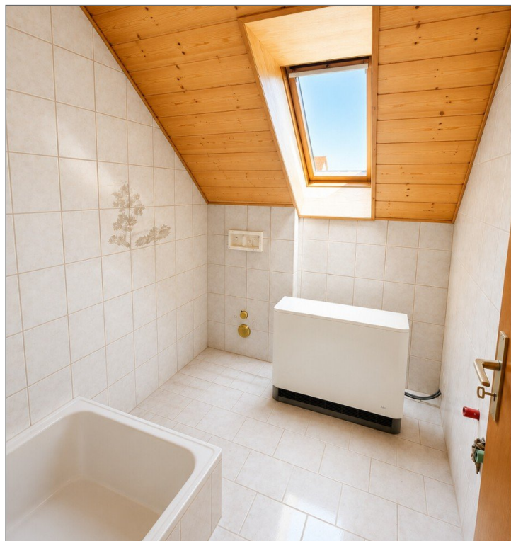
Duschbad im OG
