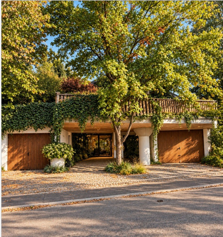
Eingangsbereich mit Garagen
